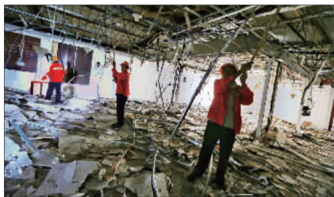
工作人员正在拆除一得阁违建的房顶
