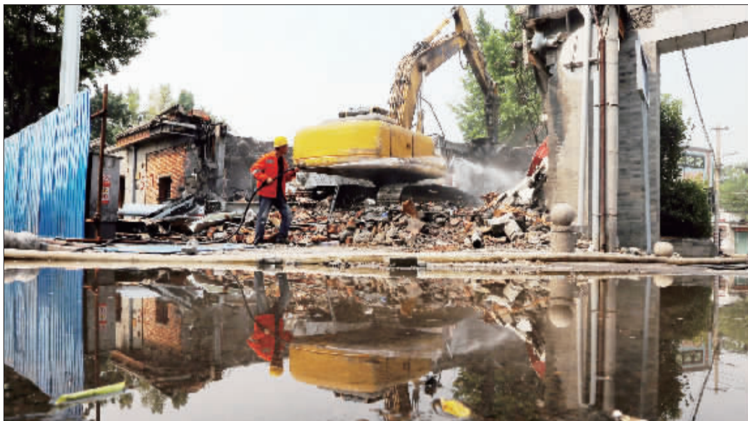
南新华街进入“拆违节奏”,拆违人员正在作业
