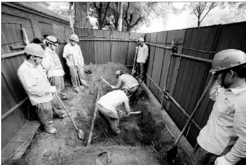
昨天下午在景山前街,工人们正在进行架空线入地施工
