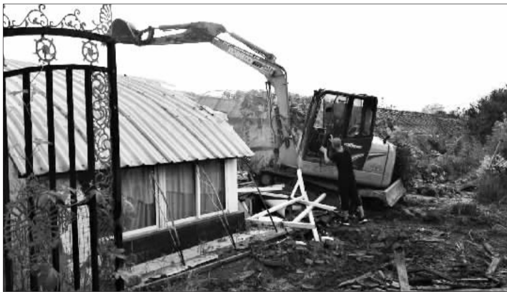
执法人员在现场将违法“大棚房”拆除
