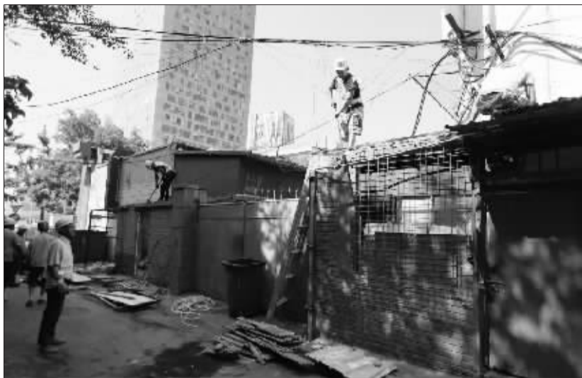
上午,工人在通州新华西街一胡同口拆除违建小板房
