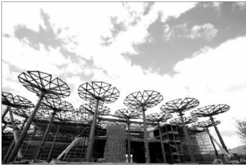
国际馆钢结构花伞目前已经吊装完成93颗
