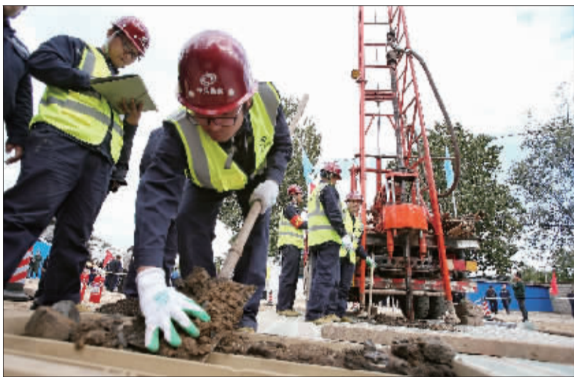
故宫北院区项目正式开展现场地质勘察和考古勘探
