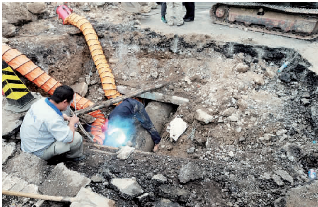
▲抢修人员正在对燃气泄漏点进行焊接
