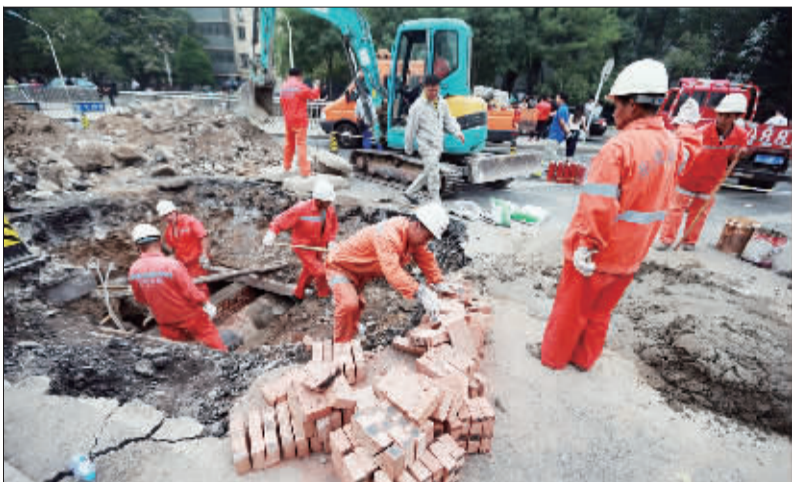
▲抢修完成,工作人员正在对泄漏点进行回填
