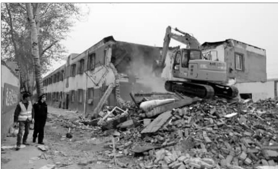
随着挖掘机的机械手臂一起一落,天景公寓的两层违建被拆除
