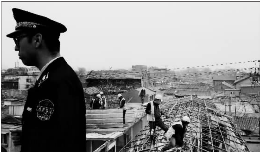
今天上午,施工人员对饶丰宾馆顶层加盖的违建进行了拆除
